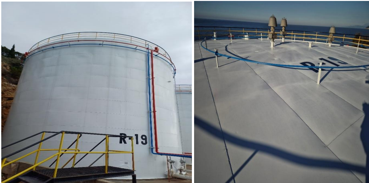
Rezervoar R-19 nakon izvršenog pjeskarenja i farbanja
