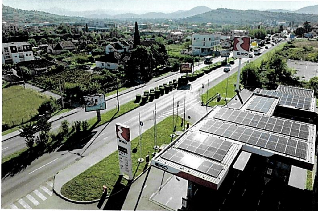
Solarna elektrana na krovu benzinske stanice Podgorica 4
