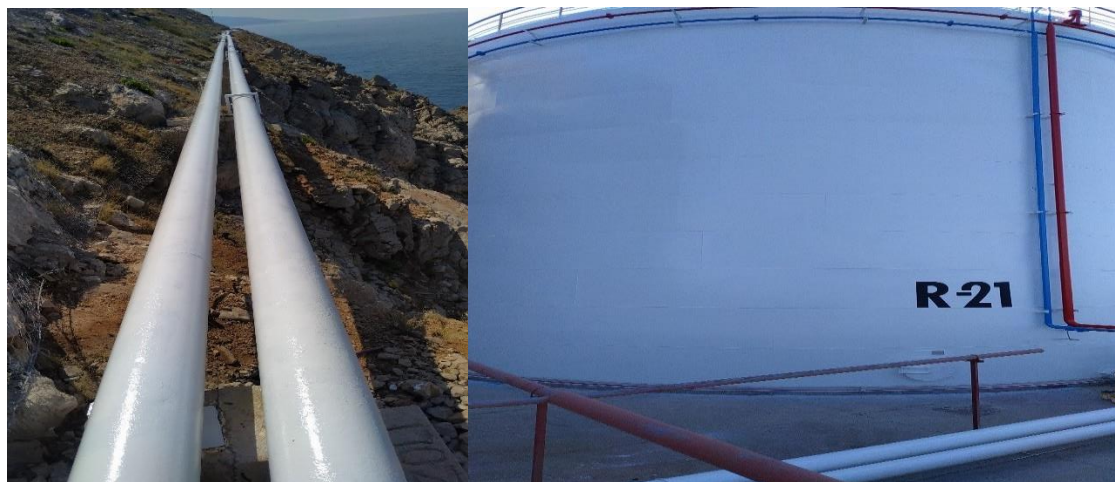
Antikorozivna zaštita cjevovoda i rezervoara
