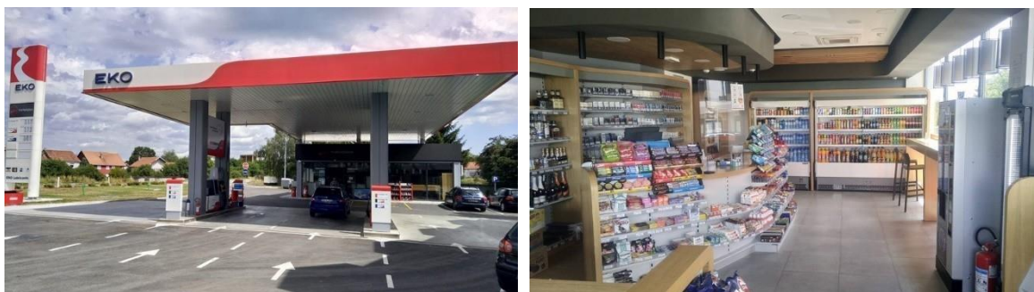
Benzinska stanica Nikšić 3 nakon rekonstrukcije
