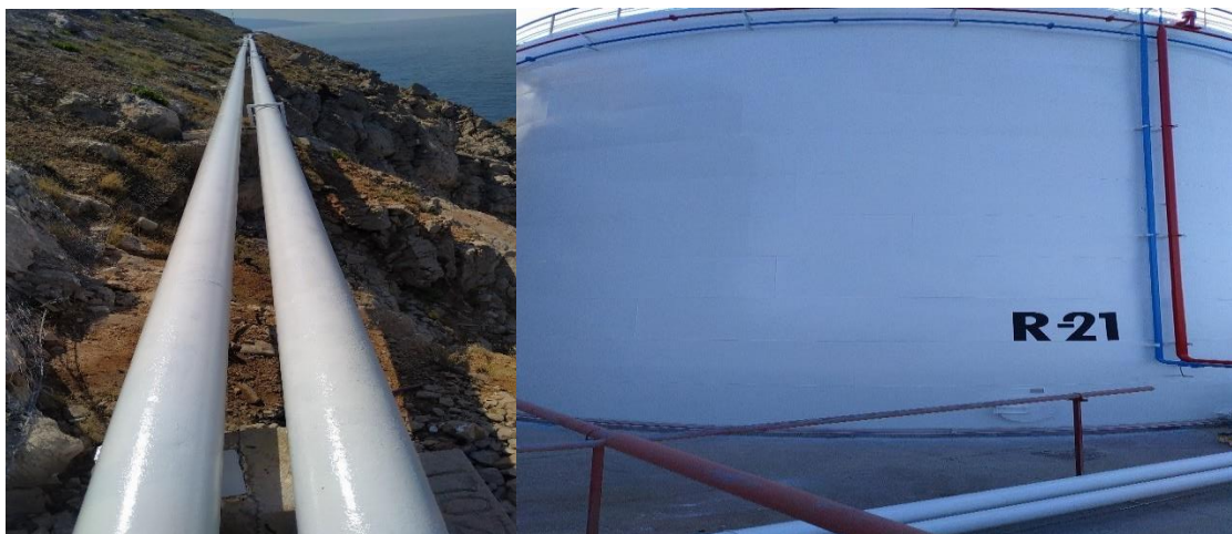
Antikorozivna zaštita cjevovoda i rezervoara
