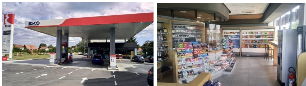
Benzinska stanica Nikšić 3 nakon rekonstrukcije
