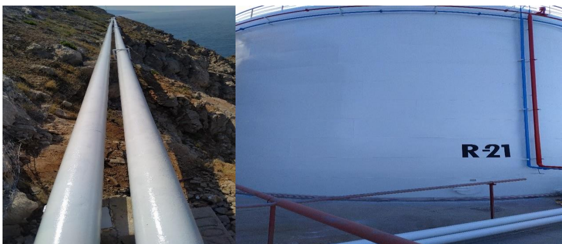
Antikoroziivna zaštita cjevovoda i rezervoara
