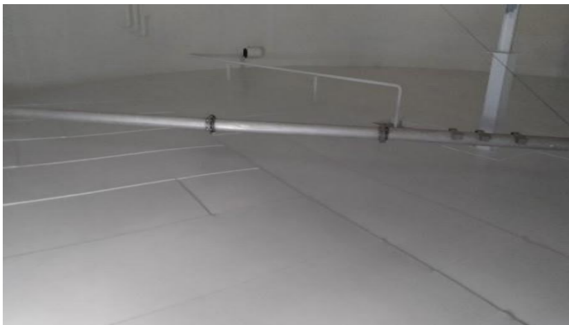
Antikorozivna zaštita cjevovoda i rezervoara
