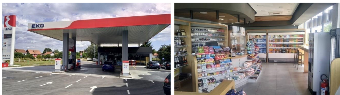
Benzinska stanica Nikšić 3 - nakon rekonstrukcije
