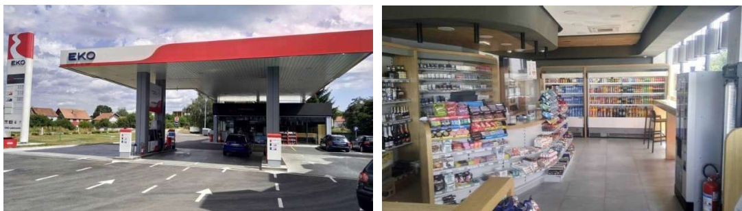
Benzinska stanica Nikšić 3 - nakon rekonstrukcije
