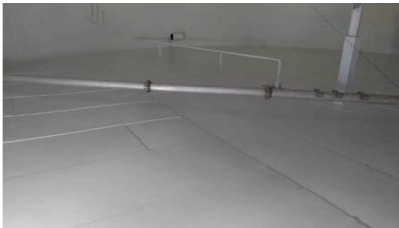
Antikorozivna zaštita cjevovoda i rezervoara
