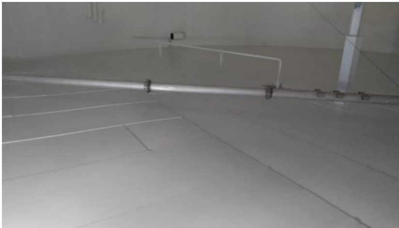
Antikorozivna zaštita cjevovoda i rezervoara
