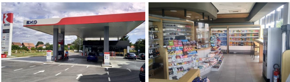
Benzinska stanica Nikšić 3 - nakon rekonstrukcije
