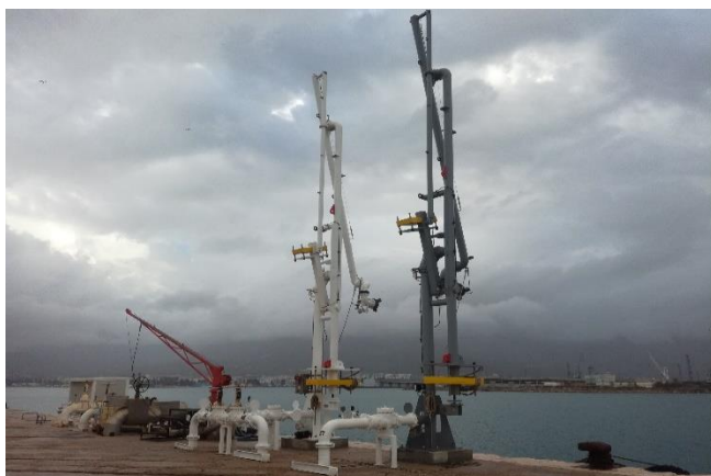
Postavljene 4 nove brodske ruke za istovar goriva iz tankera
