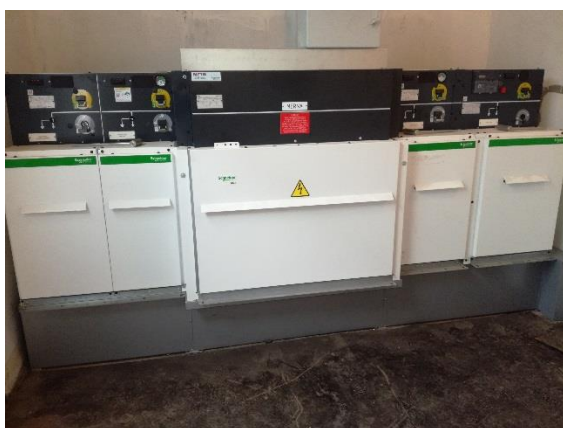
Rekonstrukcija trafostanica: Novi SN 10 kV blokovi i NN 400V
