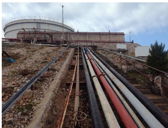
Rekonstrukcija cjevovoda, priprema linija za rezervoar R-15
