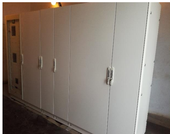
Rekonstrukcija trafostanica: Novi SN 10 kV blokovi i NN 400V
