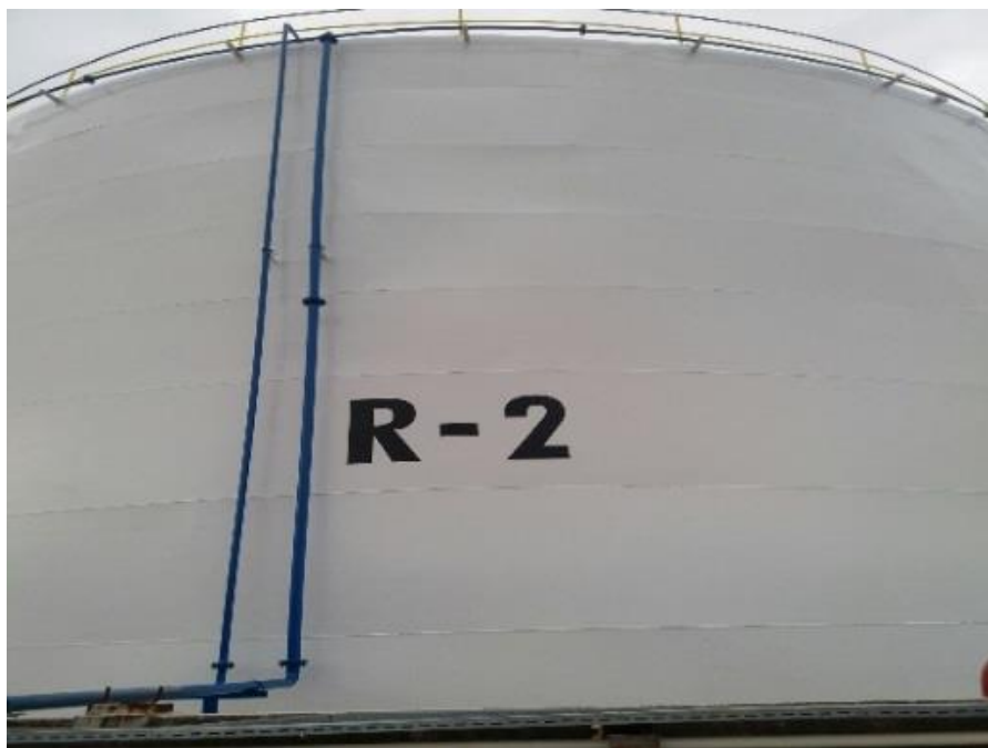
Rekonstruisani skladišni rezervoar R-2
